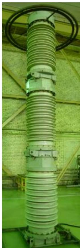
Принцип действия трансформатора напряжения основан на преобразовании посредством электромагнитной индукции переменного тока одного напряжения в переменный ток другого напряжения при неизменной частоте и без существенных потерь мощности.
