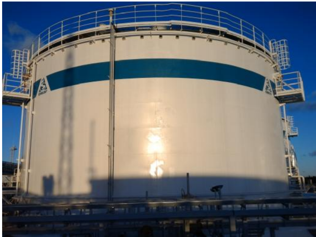
Рисунок 1 – Общий вид резервуара № 23986
