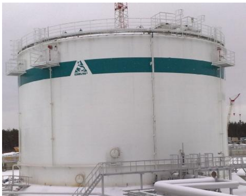
Рисунок 3 – Общий вид резервуара № 23985
