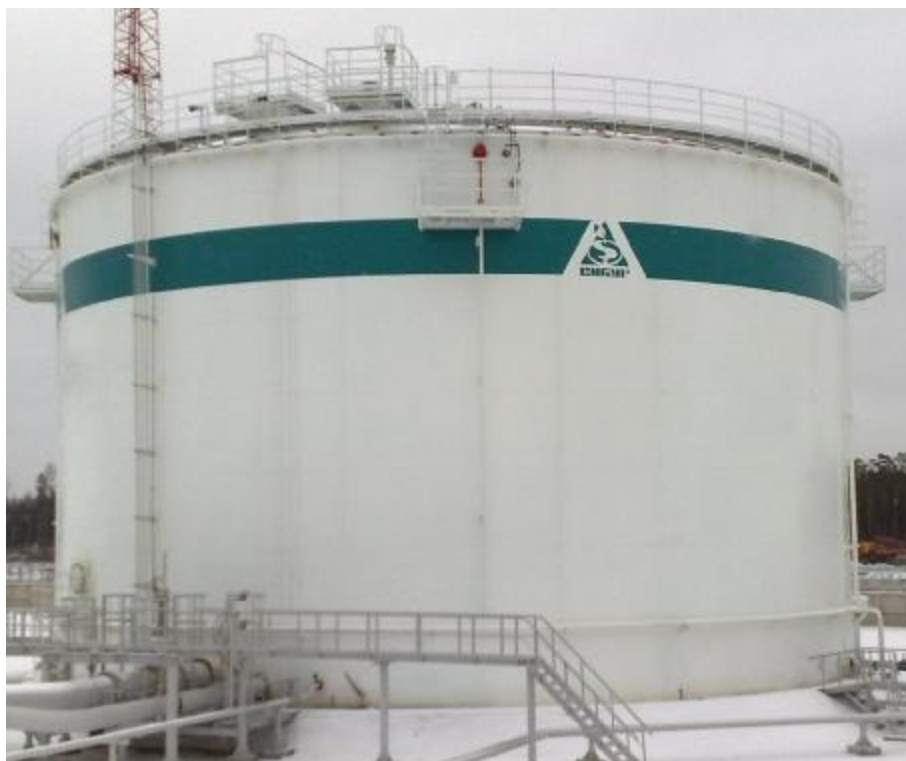
Рисунок 1 – Общий вид резервуара № 23983
