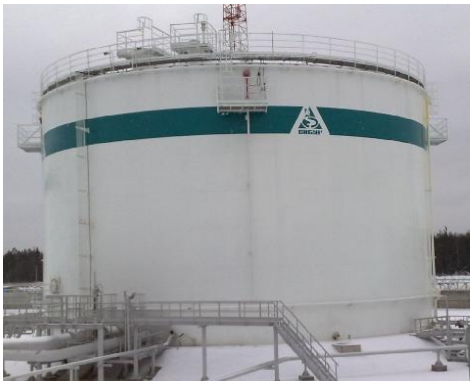
Рисунок 2 – Общий вид резервуара № 23984
