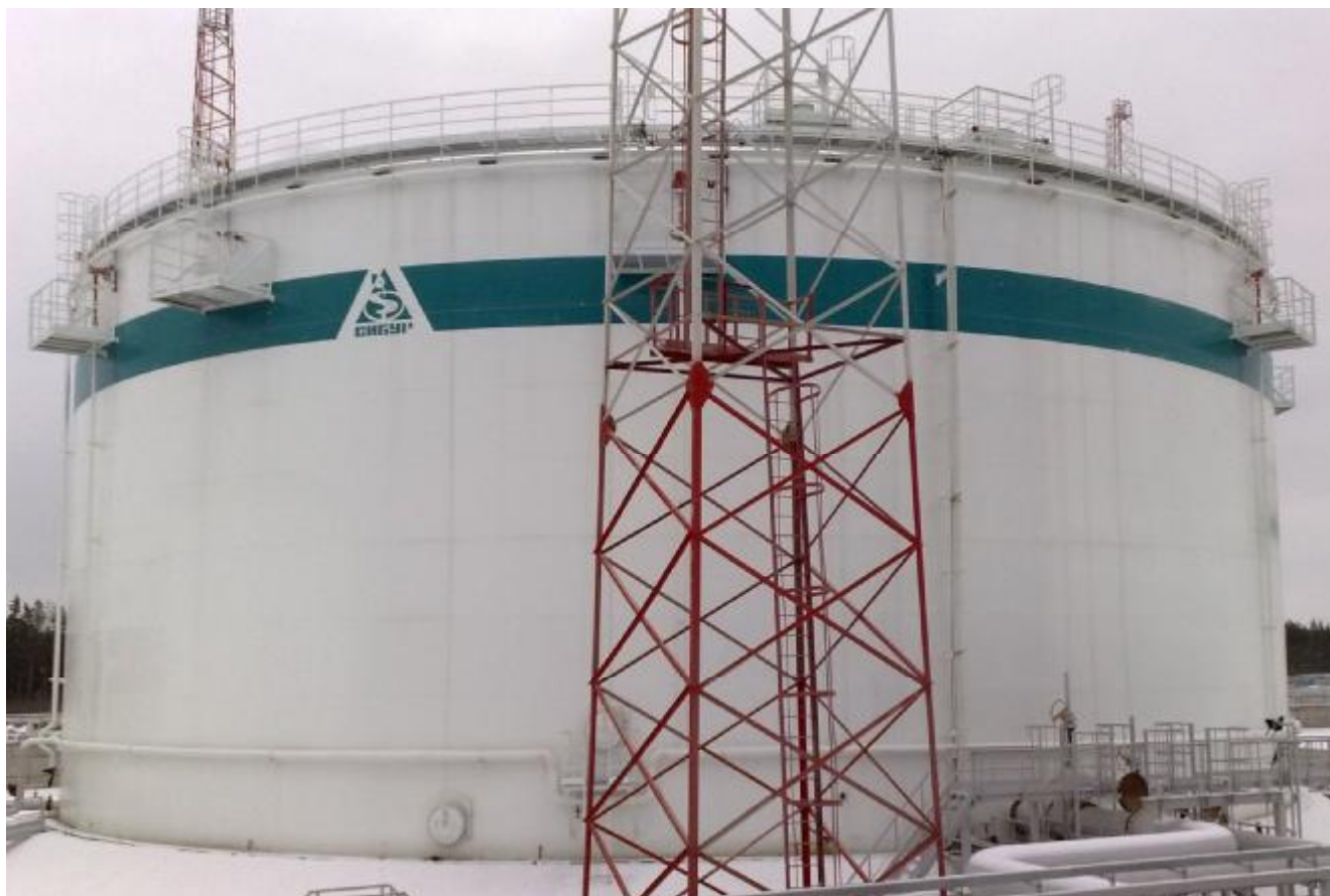
Рисунок 2 – Общий вид резервуара № 23982
