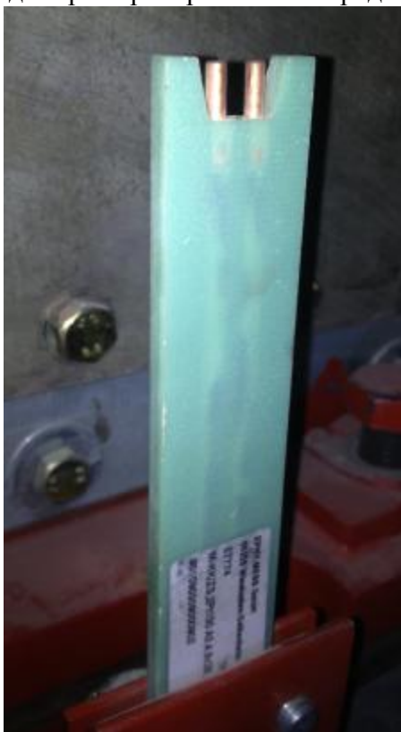
Рис. 1. Термопреобразователь сопротивления платиновый модели М-КК/ZS.
