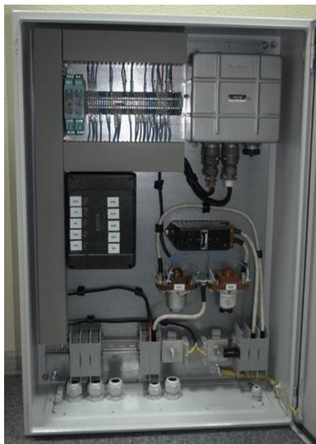
Рисунок 4 Шкаф температурных параметров
