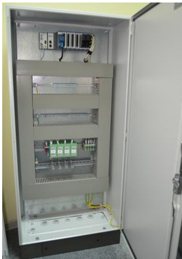
Рисунок 4 Шкаф температурных параметров
