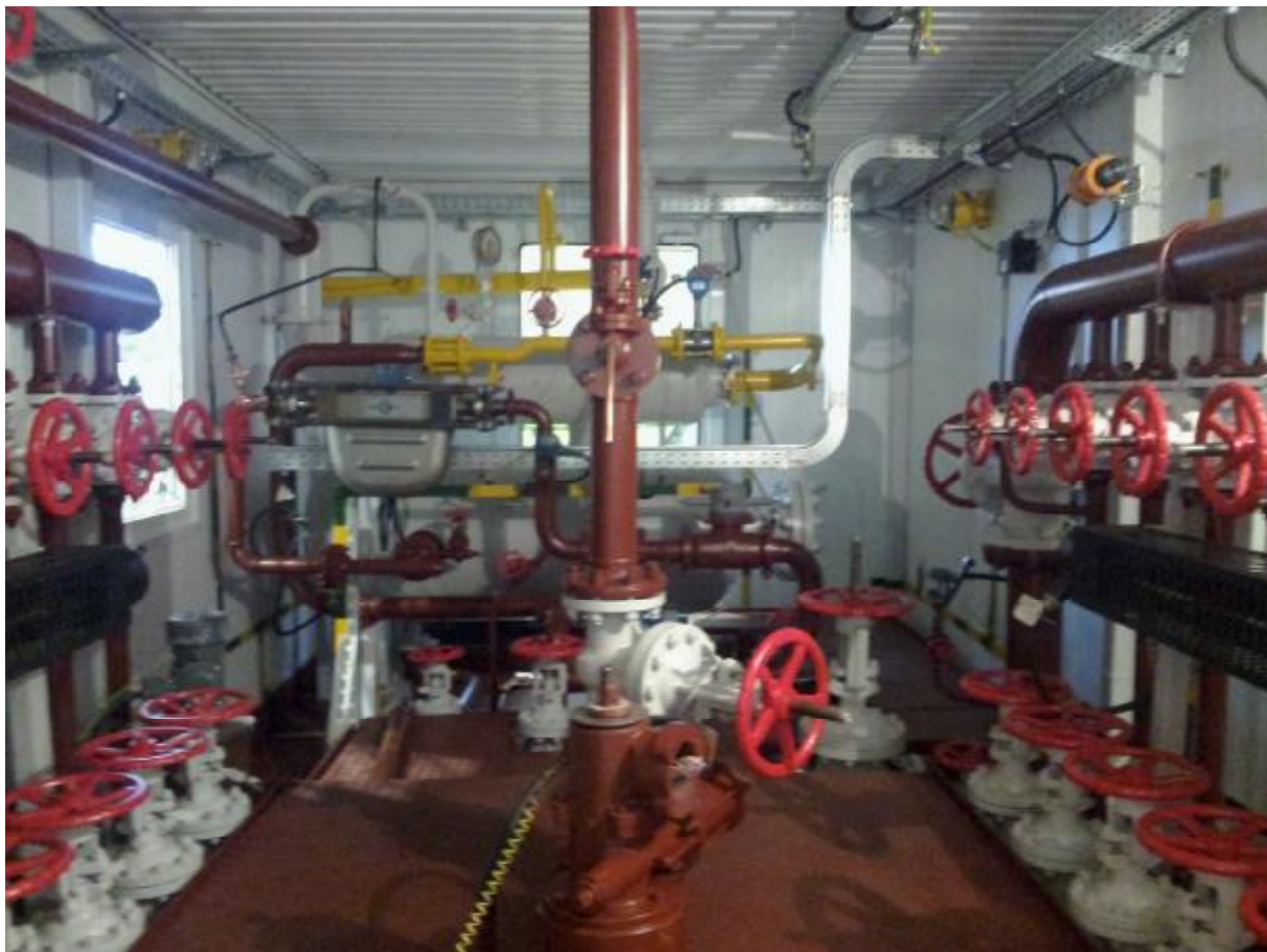
Рисунок 1 - Установка измерительная «Мера-ММ.31». Общий вид.
