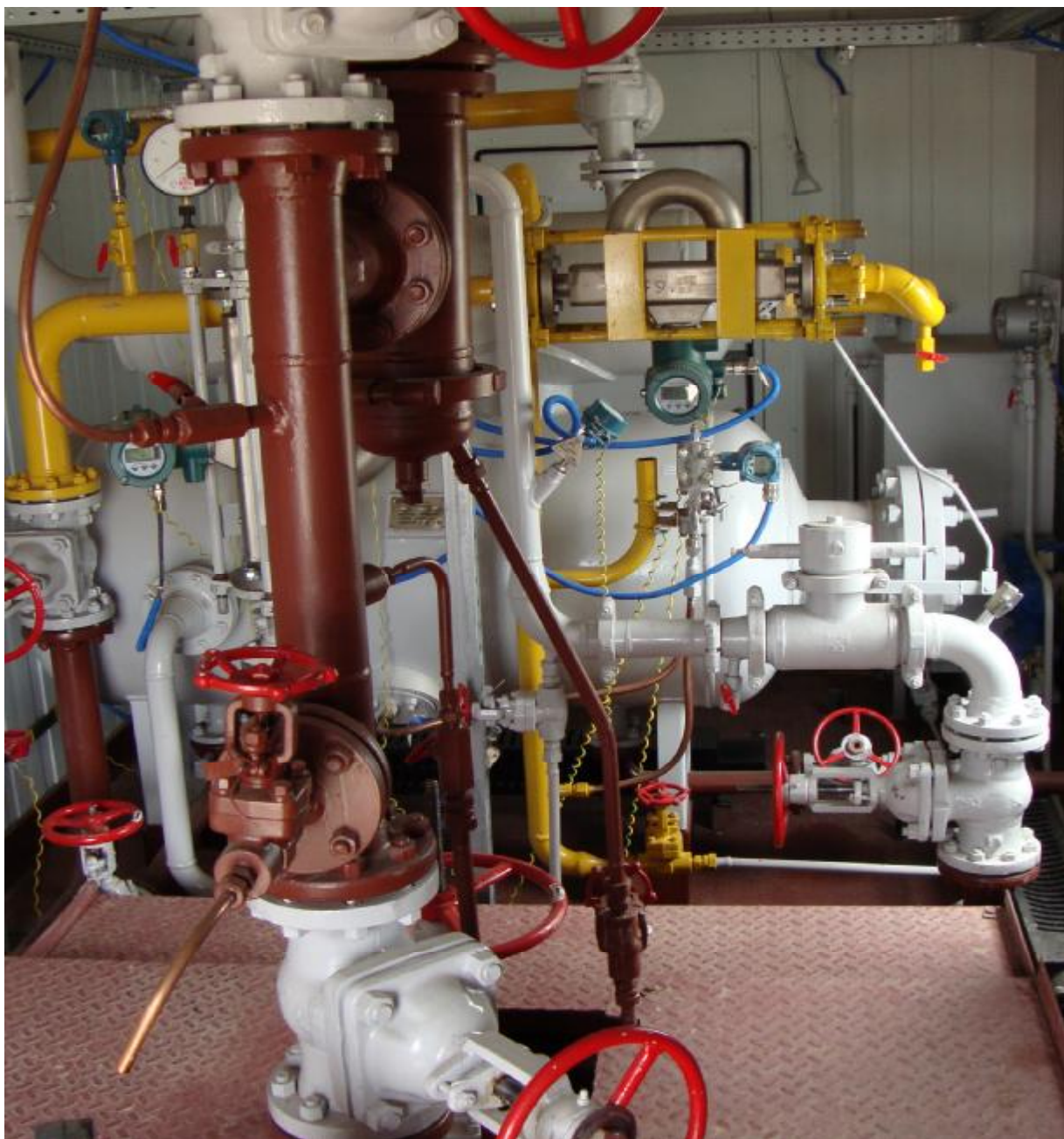
Рисунок 1 - Установка измерительная «Мера-ММ.4Х». Общий вид.
