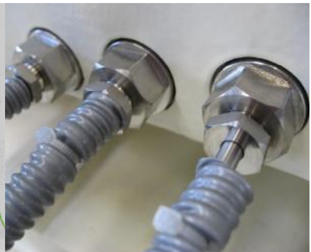
Рисунок 4 – датчики температуры WB 91, установленные в агрегат
