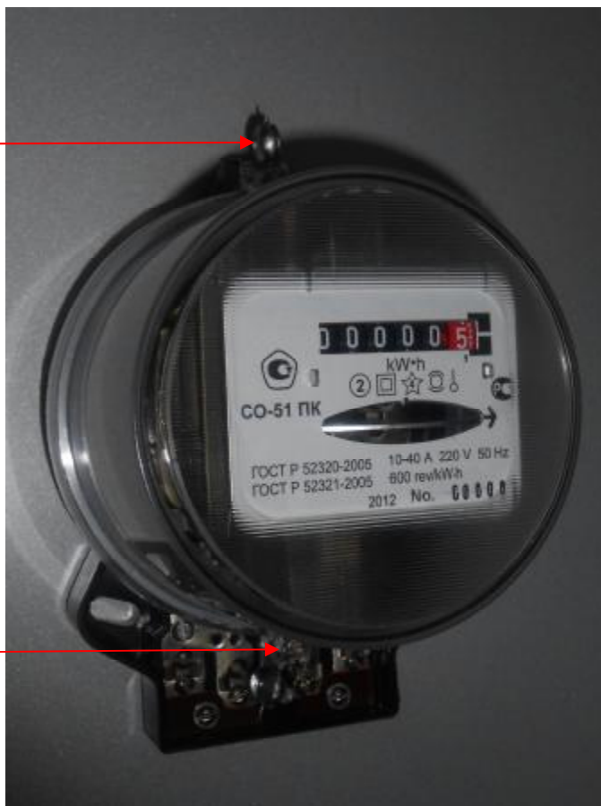
Рисунок 1. Общий вид счетчика и места пломбирования
